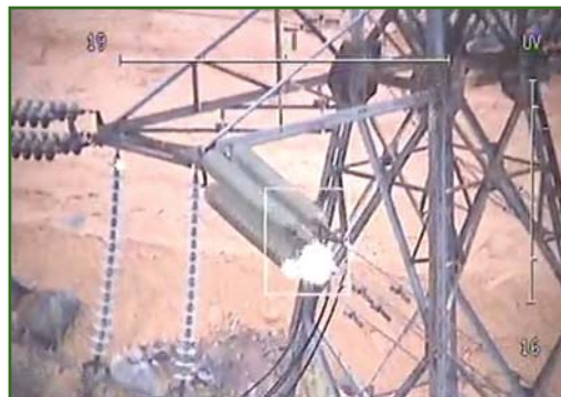
Рис. 7 Коронные разряды в УФ-спектре
